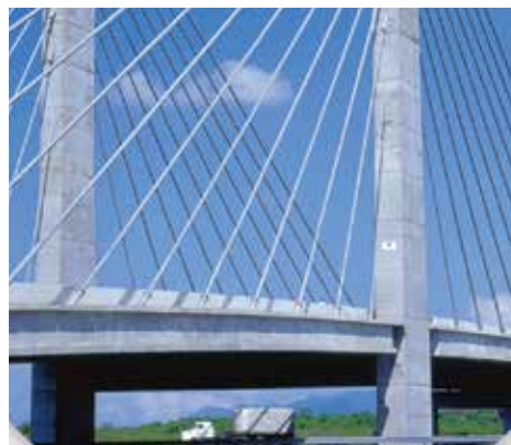
Utilização de cordoalha estaiada na Rodovia dos Imigrantes (SP).
