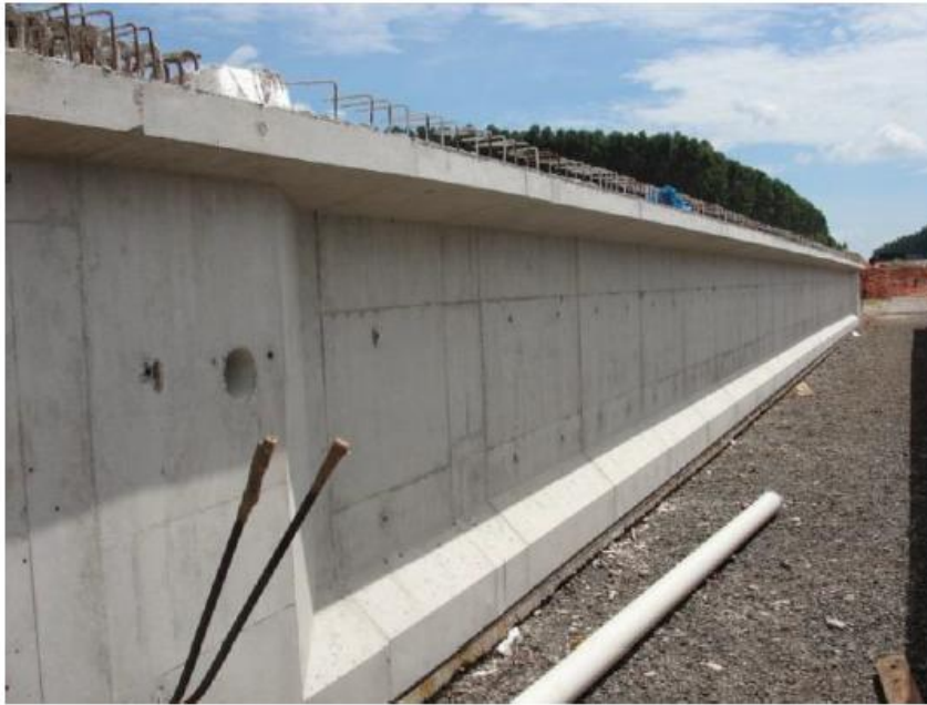
Figura 1.42 – Viga protendida pós-tensionada com ancoragem Rudloff para superestrutura de viaduto em rodovia. (Fotografias do Autor)
