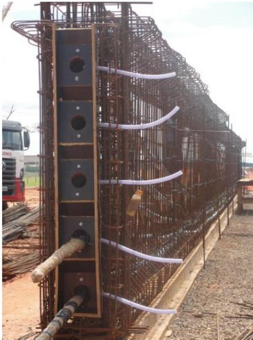
Figura 1.44 – Montagem das armaduras passivas e bainhas metálicas para confecção de uma viga pós-tensionada pré-moldada para superestrutura de viaduto em rodovia. (Fotografias do Autor)
