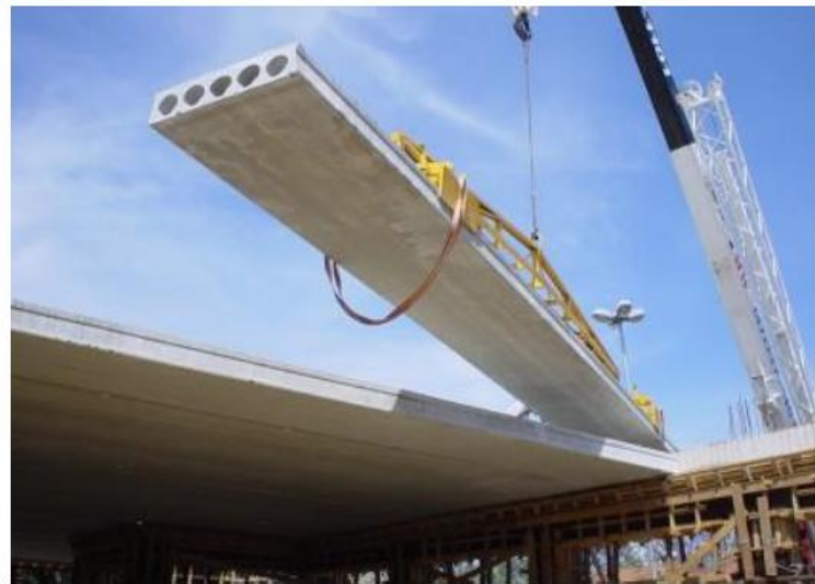
Figura 1.9 – Laje alveolar protendida pré-moldada.
