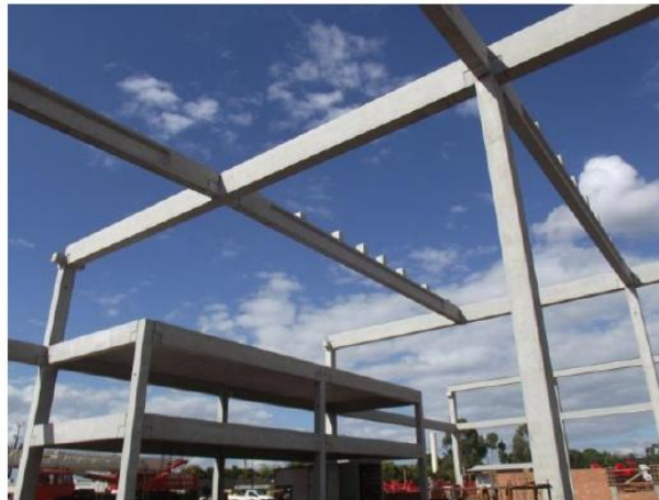
Figura 1.7 – Vigas pré-moldadas protendidas seção retangular e I, para cobertura de galpão. (Cortesia: Marka Soluções Pré-fabricadas, www.marka.ind.br )
