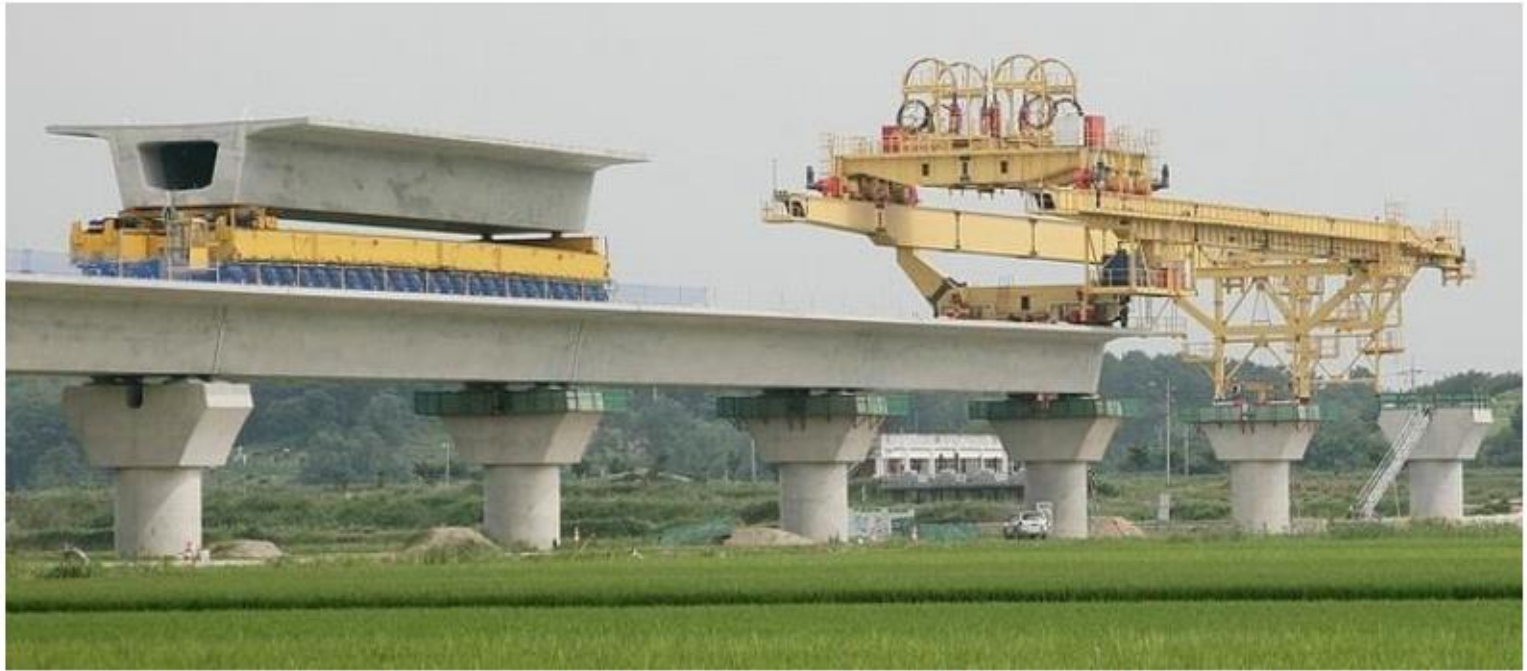
Figura 1.13 – Viga pré-moldada seção celular (caixão) em viaduto. (Fonte: Dorman Long Technology, http://www.dormanlongtechnology.com )
