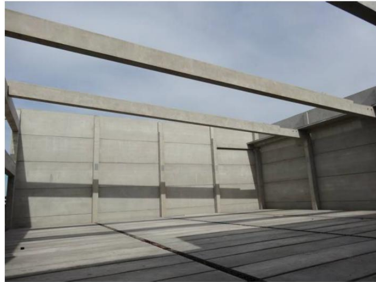
Figura 1.4 – Viga pré-moldada protendida de seção retangular, com vão de 28 m, para cobertura de edifício de três pavimentos. (Cortesia: Marka Soluções Pré-fabricadas, www.marka.ind.br )
