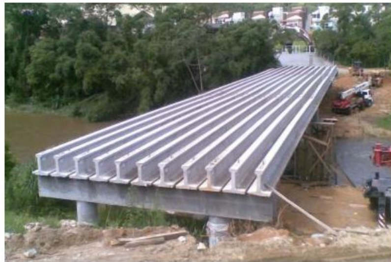
Figura 1.10 – Vigas biapoiasdas pré-moldadas seção I em superestrutura de ponte.
