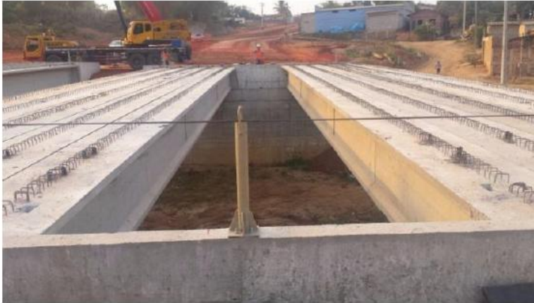
Figura 1.11 – Vigas biapoiadas pré-moldadas seção I em superestrutura de viaduto (Fonte: Mold Estruturas, http://mold.com.br )
