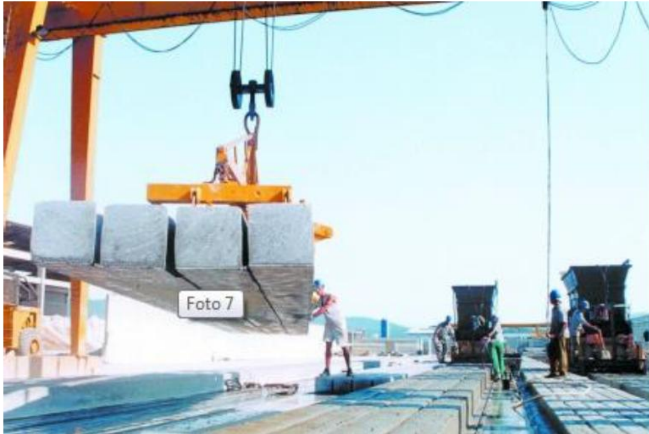
Figura 1.22 – Estaca pré-moldada protendida. (Fonte: Protensul, http://www.protensul.com.br )
