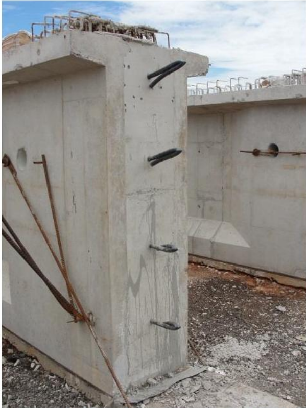
Figura 1.45 – Viga protendida pós-tensionada pré-moldada finalizada, para superestrutura de viaduto em rodovia. (Fotografias do Autor)
