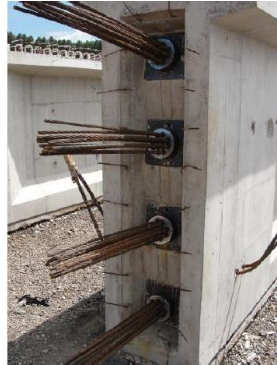
Figura 1.42 – Viga protendida pós-tensionada com ancoragem Rudloff para superestrutura de viaduto em rodovia. (Fotografias do Autor)
