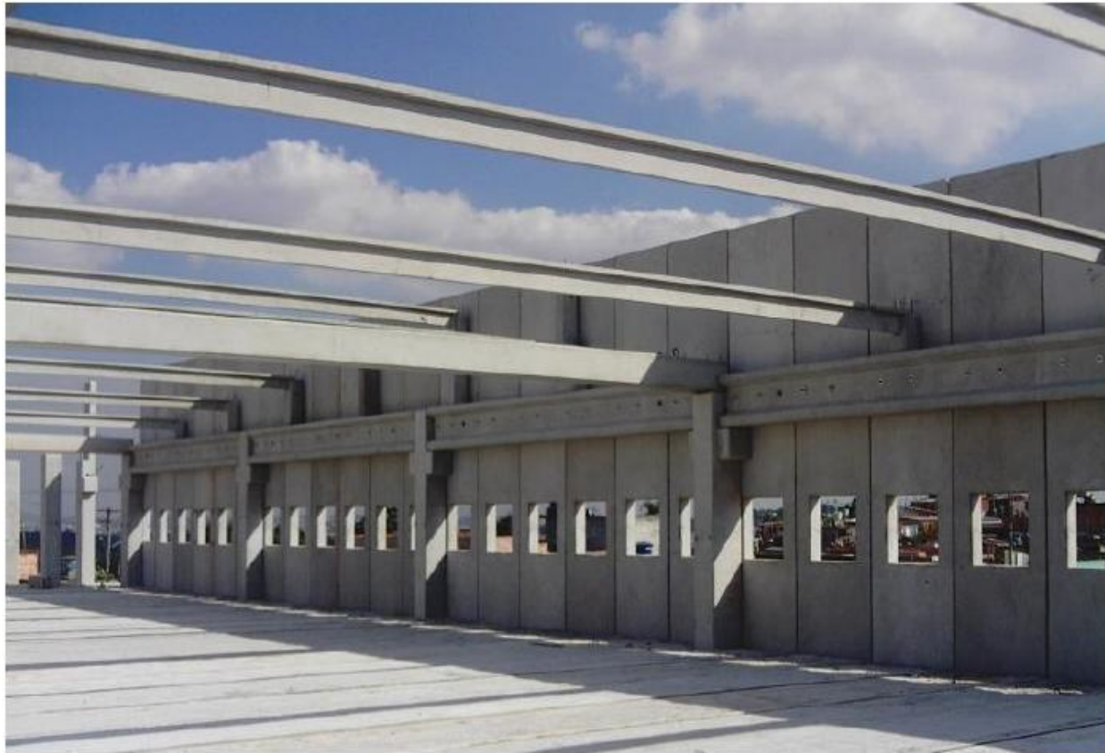
Figura 1.8 – Viga pré-moldada protendida seção T, para cobertura. (Fonte: Protendit, https://www.protendit.com.br )
