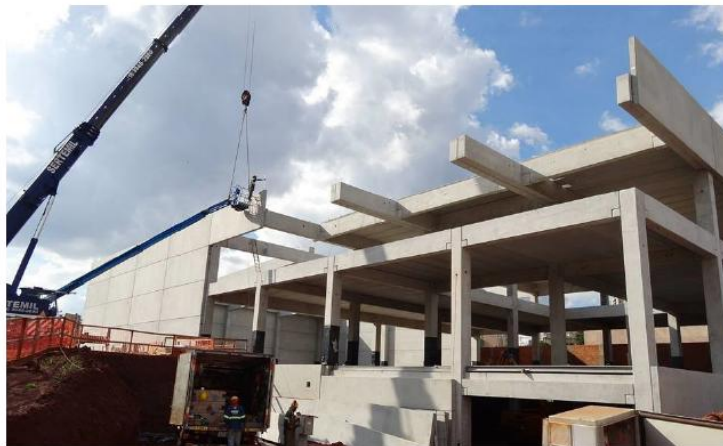
Figura 1.5 – Viga pré-moldada protendida de seção retangular, com vão em balanço, em edifício de três pavimentos. (Cortesia: Marka Soluções Pré-fabricadas, www.marka.ind.br )
