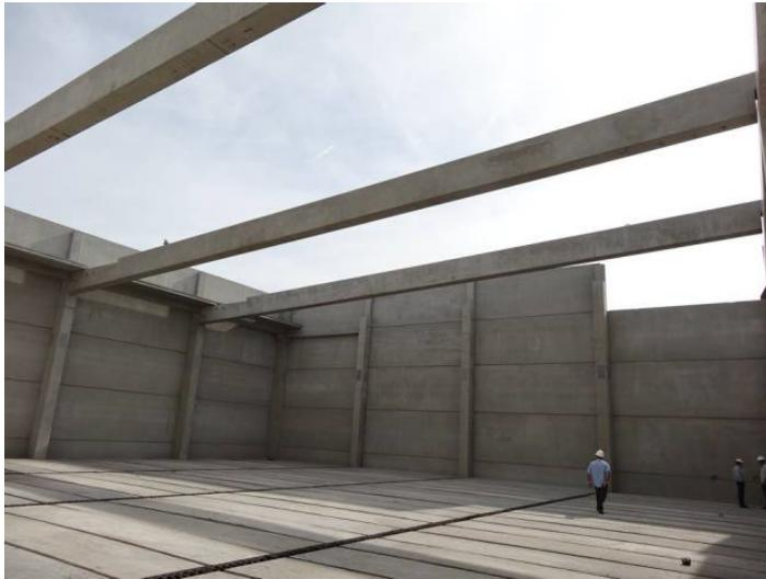
Figura 1.4 – Viga pré-moldada protendida de seção retangular, com vão de 28 m, para cobertura de edifício de três pavimentos. (Cortesia: Marka Soluções Pré-fabricadas, www.marka.ind.br )
