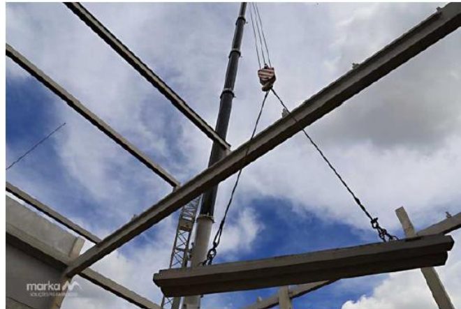
Figura 1.6 – Viga pré-moldada protendida seção I, com vão de 25 m, para cobertura de galpão. (Cortesia: Marka Soluções Pré-fabricadas, www.marka.ind.br )
