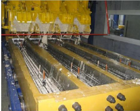
a) lançamento do concreto nas fôrmas metálicas, com os fios previamente estirados e ancorados na própria fôrma;
