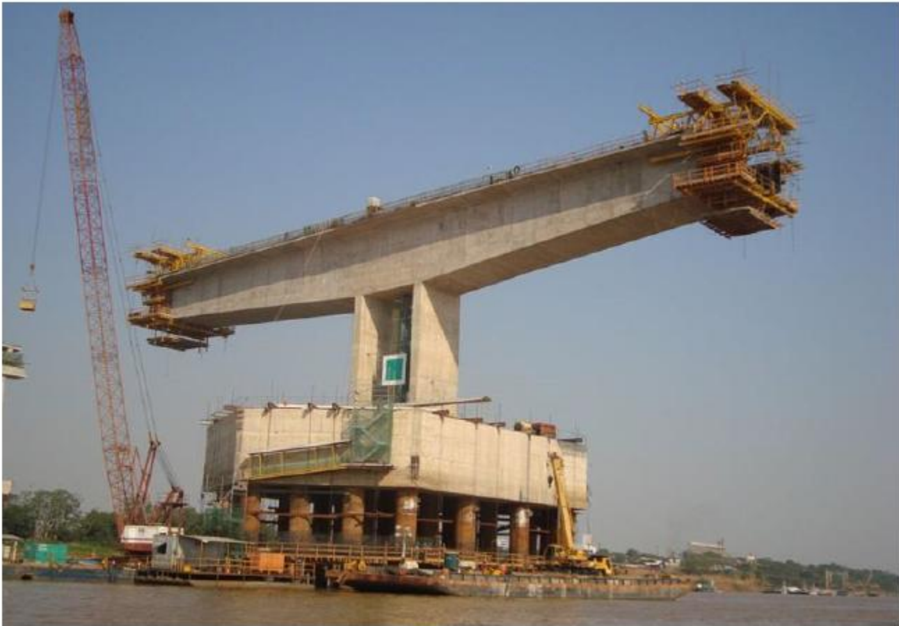
Figura 1.14 – Ponte com aduelas moldadas no local, com viga protendida de seção celular (caixão), sobre o rio Madeira. (Fonte: Ulma Construction, http://www.ulmaconstruction.com.br )
