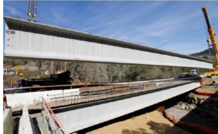
Figura 1.12 – Vigas biapoiadas pré-moldadas seção I em superestrutura de viaduto. (Fonte: National Precast Concrete Association, http://precast.org )
