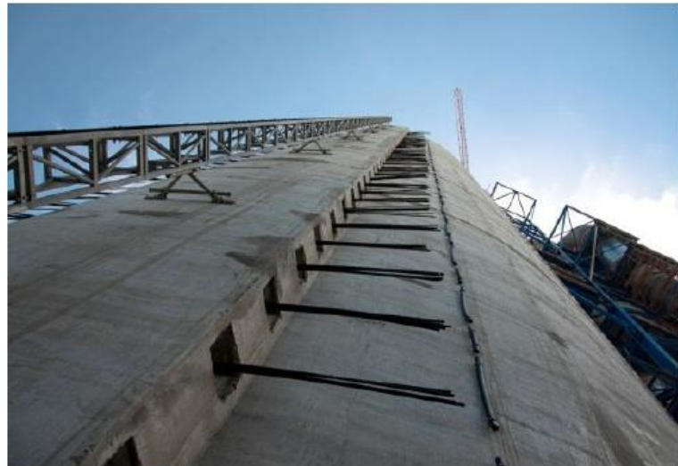
b) cabos o de protensão com cordoalhas.
