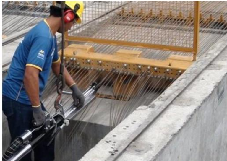
Figura 1.33 – Operação de estiramento de cordoalhas e fios na ancoragem ativa da pista de protensão. (Fonte: Weiler-C.Holzberger Ind. Ltda, http://wch.com.br )
