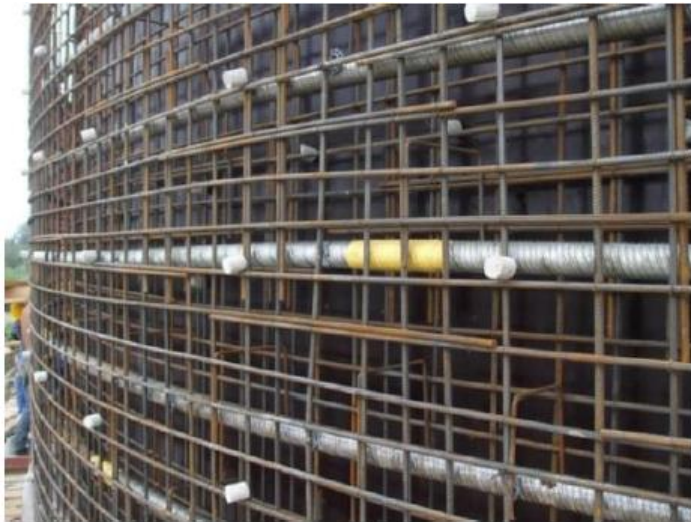
a) bainhas metálicas entre armaduras passivas;
