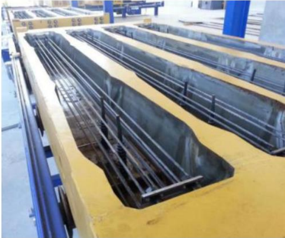
a) fôrma metálica com os fios de protensão posicionados;
